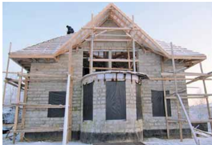
В силу малого веса строительство из полистиролбетона может вестись небольшой бригадой без дорогостоящей техники
